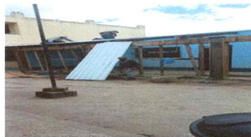
SUSTITUCION DE VIGAS DE MADERA POR CONCRETO CORREDOR DE ESCUELA
