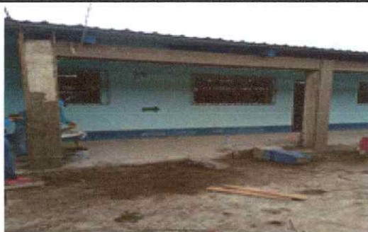
SUSTITUCION DE PILARES DE MADERA POR CONCRETO EN CORREDOR
