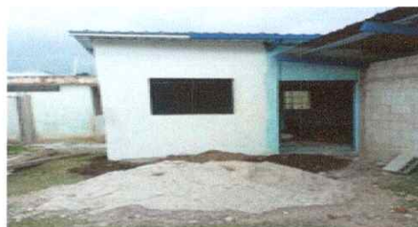
Cambio de techo de cocina
